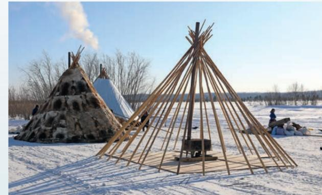
Tchoum en construction dévoilant sa structure
